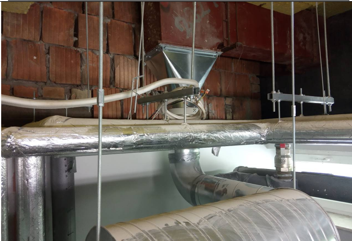
FOT. 3 Widok wewn. na nieotynkowany fragment ściany z bloczków ceramicznych (powyżej +3,20m. nad posadzką, oraz na istniejące instalacje wentylacji oraz wody użytkowej)
