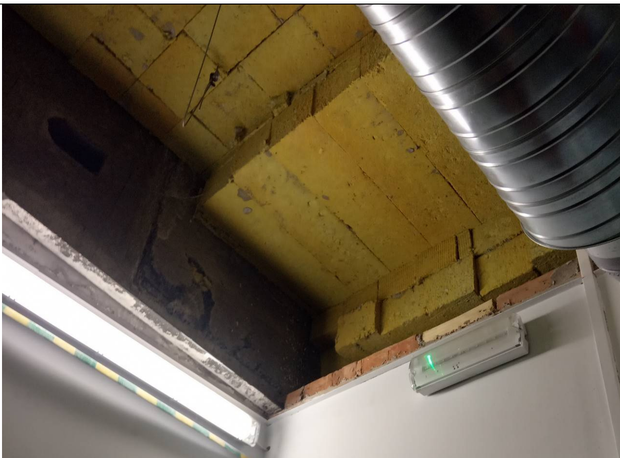
FOT. 5 Widok wewn. – pocieplenie płyt stropowych wełną mineralną gr 18cm
